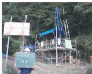
地すべり地のボーリング作業中
