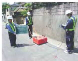
空洞調査・地下レド測定中
