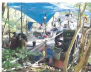
トンネル調査・水平ボーリング中
