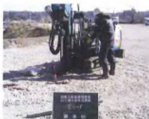
土壌汚染試験試料採取中
